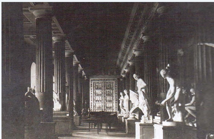
Zdjęcie Sali Kolumnowej z 1862 r. z drewnianą posadzką Photo of the Columned Hall from 1862 with a wooden floor
